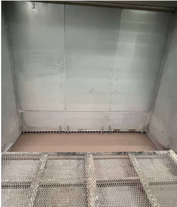
塗装ブース内の汚れがひどい
